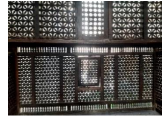
صورة ٤٠ توضح بعض مشربيات نوافذ بيت السحيمي وآلية عملها من حيث تقليل الإبهار الضوئي بالفراغ الداخلي (المصدر: الباحث)
