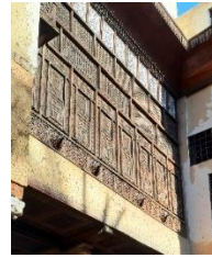
صورة ٤٠ توضح بعض مشربيات نوافذ بيت السحيمي وآلية عملها من حيث تقليل الإبهار الضوئي بالفراغ الداخلي (المصدر: الباحث)
