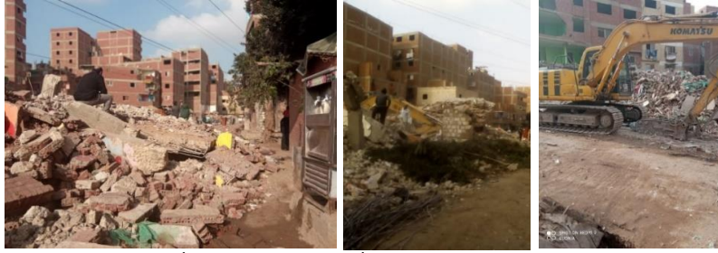
شكل 9-10-11: عزبة الهجاة أثناء عمليات الهدم بأيام مختلفة
