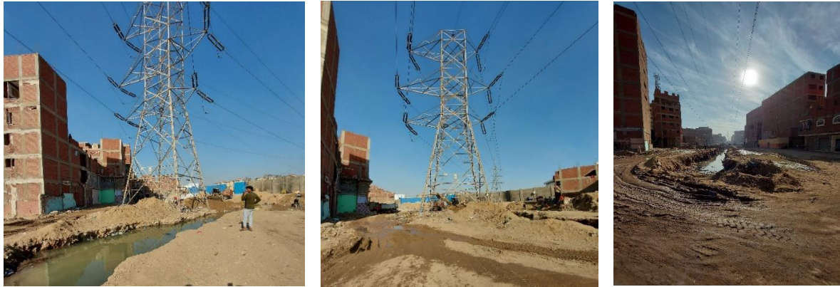
شكل 6-7-8: الضغط العالي بعزبة الهجانة بعد إزالة المساكن أسفله وبداية الحفر من أجل دفنه تحت الأرض
