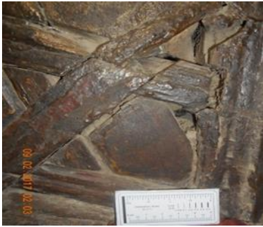
شكل (3) توضيح فقد وتخلخل في الحشوات
