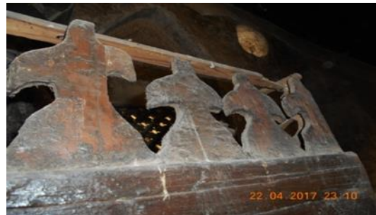
شكل (1) توضيح تراكم الأتربة ما بين خشب الخرط
