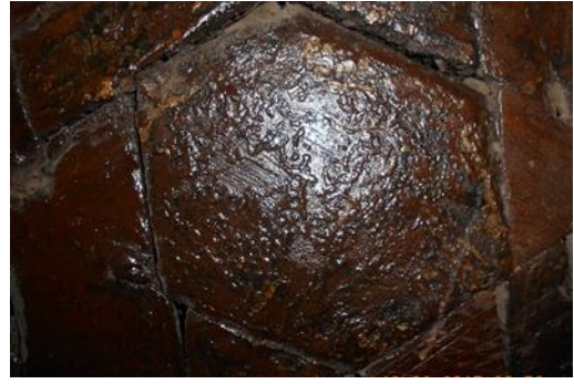
شكل (8) يوضح تلف وتجدد طبقة الورنيش الحديث
