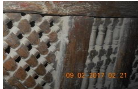
شكل (1) توضيح تراكم الأتربة ما بين خشب الخرط
