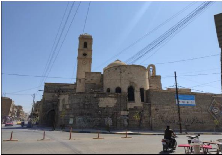
المصدر: الجولة الميدانية ٢٠٢١/١٠/١٢
