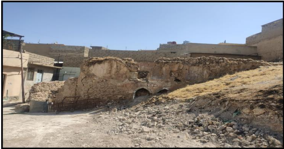
المصدر: الجولة الميدانية ٢٠٢١/١٠/١٥
