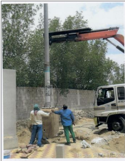
صورة (*) أعمال تركيب أعمدة الإضاءة مخطط الزهراء منطقة الشرائع، عام ٢٠٢٢م
