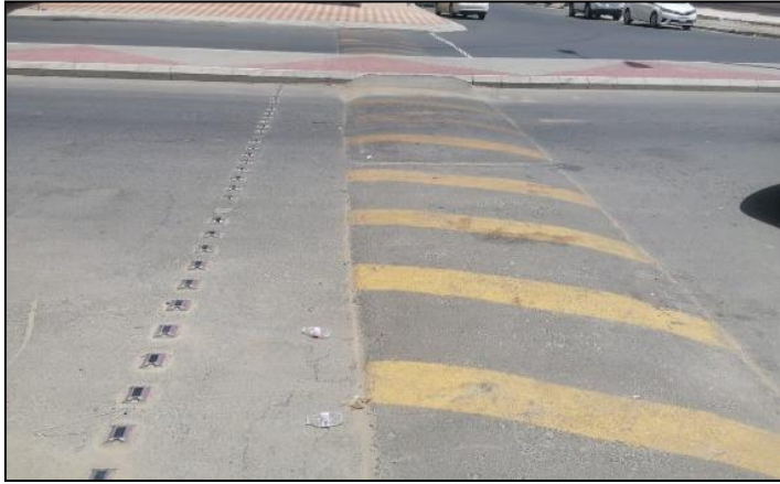
صورة (٣) مطب مستوى Flat pump – حي العمرة الجديدة
