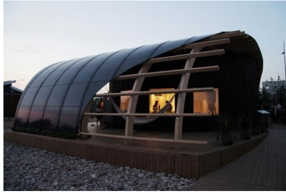
شكل (7) تكامل الخلايا الشمسية الرقيقة مع تصميم الهيكل باعتبارها مادة إنهاء خارجية
