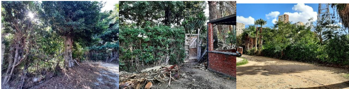
شكل ٢، لقطات لمدخل مشتل قصر طوسون وسوء تصميم حدوده الخارجية مما يؤدي لفقد محيط المشتل للجانب الجمالي والوظيفي في التواصل مع الحيز الملحق به إلى جانب قلة المداخل التي تسهل الوصول للحيز الداخلي للمشتل (الباحثة)
