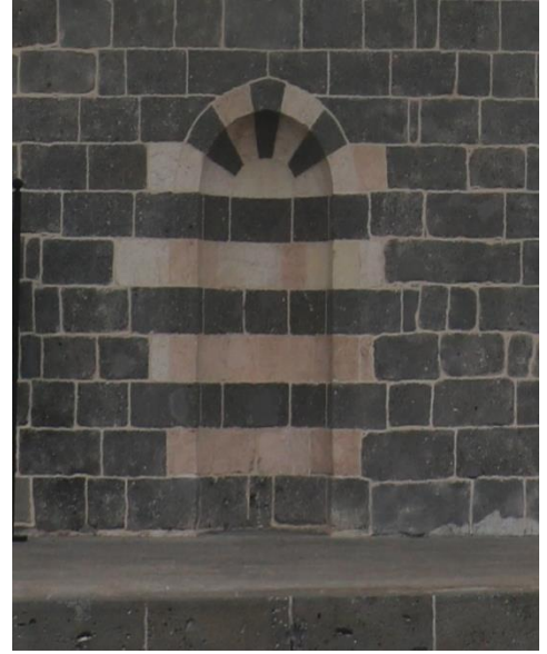
لوحة (٥) إحدى الدخلات التي تكتنف المدخل الرئيسي و التي كانت تؤدي دور المحراب (تصوير الباحث)
