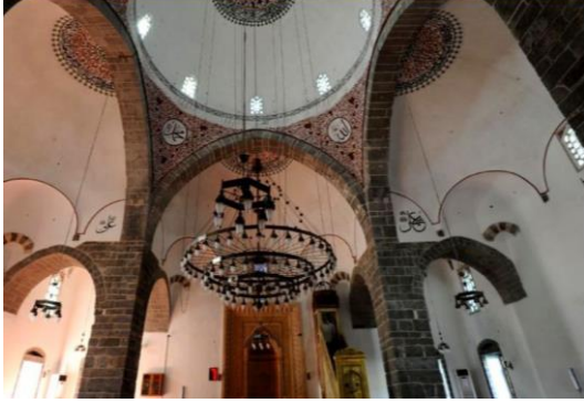
لوحة (١٥) تظهر مناطق الإنتقال و الدعامات الخاصة بالقبعة المركزية (تصوير الباحث)
