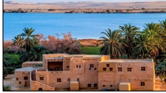
صورة (٨) توضح شكل البيوت وبحيرة سيوة
