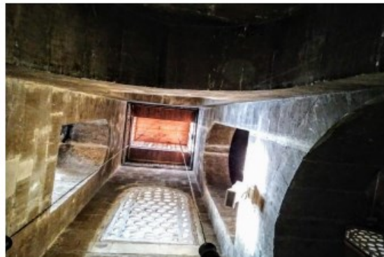
الشكل (١١): ملاقف الهواء الموجود في قبة الدفن بمسجد جاني بك الأشرفي (٧٩)
