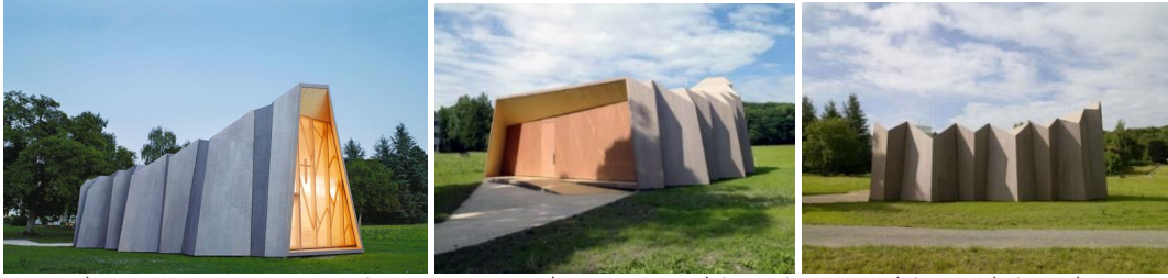
شكل (23) يوضح الواجهة المعمارية لمبنى كنيسة مؤقتة لراهبات سانت لوب- تصميم شركة Local architecture والمعماري Danilo
