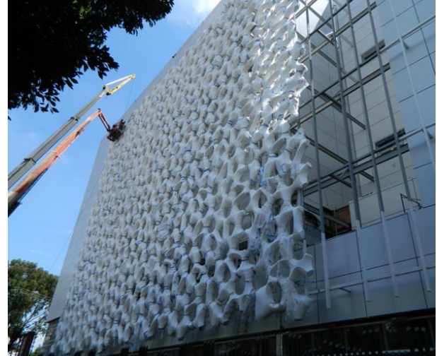
شكل (2) يوضح الغلاف الخارجي للواجهة الرئيسية المكون من الواح (GRC) أثناء تركيبه.
