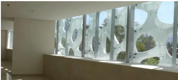
شكل (1) يوضح مشروع مُستشفى جيا جونزاليس التخصصي وواجهاته المُستخدم فيها ألواح (GRC) ذات تقنية تنقية الهواء.
