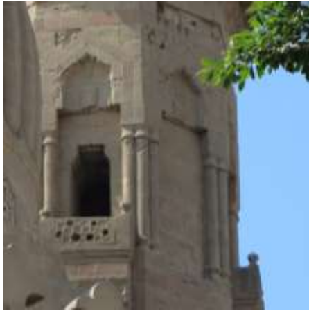
لوحة (٤) عقد منكسر يتوج إحدى مضاهيات مؤذنة مدرسة أم السلطان شعبان، تصوير الباحثة
