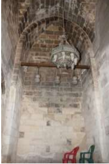
لوحة (٣٣) قبو ذو ثلاثة جوانب يغطي مضاهية دركاة مدخل خانقاة الأمير شيخو بالصليبية، تصوير الباحثة
