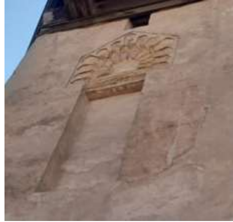
لوحة (١) عقد منكسر يتوج إحدى مضاهيات مؤذنة زاوية الهند، تصوير الباحثة
