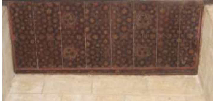
لوحة (٢٩) سقف خشبي يغطي مضاهية دركاة مدخل مدرسة قايتباي بقلعة الكيش، تصوير الباحثة
