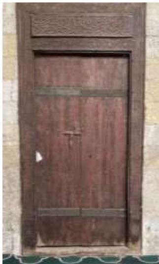
لوحة (٤٣) باب خشبي مصفح بأشرطة معدنية بمضاهية الإيوان الشمال الغربي بمدرسة الأشرف برسباي بشارع المعز، تصوير الباحثة
