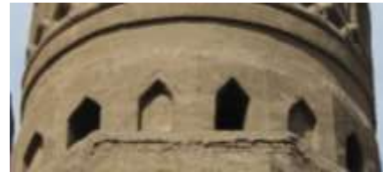
لوحة (٥) عقد منكسر يتوج مضاهيات رقية القبة بمدرسة تغري بردي، تصوير الباحثة
