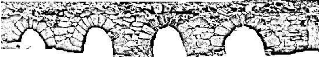
(شكل: ٨) : ١١٠ القناطر التي تربط بين الأحواض والقصر بالعلوية وهي من صنجات معشة والعقود مدببة الشكل. عمل الباحث
