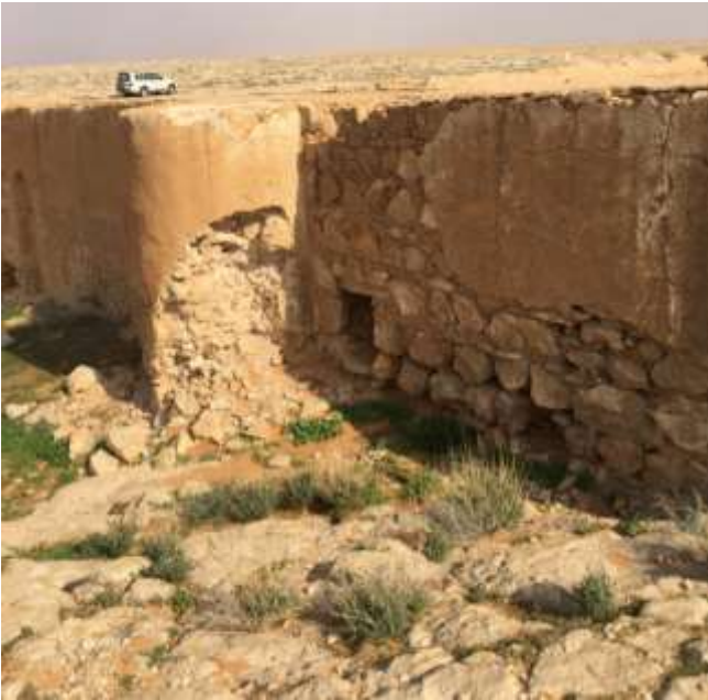
(لوحة: ٤): الجدار الغربي و دعامات بركة العشار (بطان) من الخارج ويظهر من جدرانها تقنية البناء. تصوير الباحث
