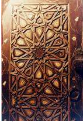
( صورة ٦ ) : جزء من حشوة باب زخارفها منفذة بطريقة التعشيق
