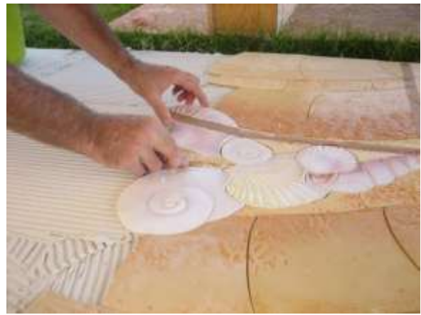
شكل رقم (١٧) يوضح عملية التثبيت لاجزاء البلاطات وان كانت مشكلة باشكال متعددة ايضاً
