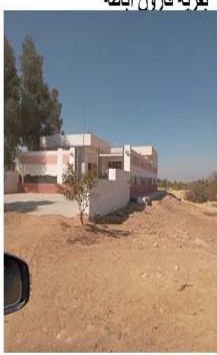
صورة (١٠) محطة صرف صحي يوسف الصديق
