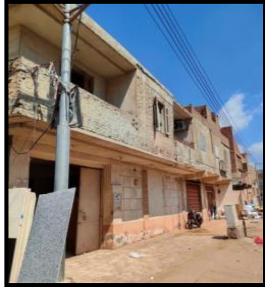
صورة (٢٥) جانب من المباني المشيدة بحوائط حاملة وأسقف خرسانية بشوارع دابر الناحية الغربية
