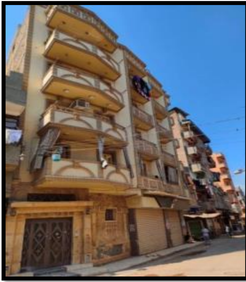
صورة (٢٦) جانب من المباني المشيدة بأعمدة وأسقف خرسانية بشياخة التحرير
