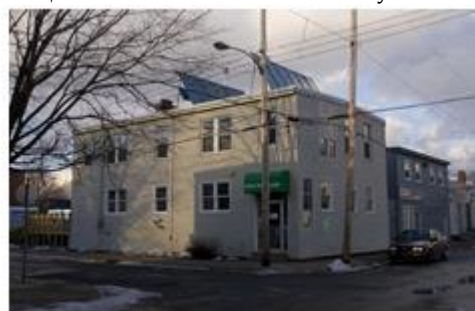
شكل 13: مكتب مركز العمل البيئي Ecology Action Centre Office [13]
