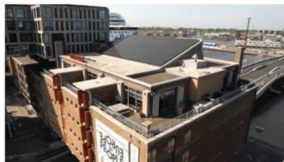
شكل 15: صورة توضح استخدام الخلايا الضوئية بمبنى [15] Pakhuis De Zwijge.
