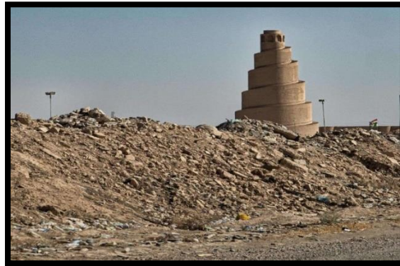
لوحة (١٨) لمخلفات البناء في مدينة سامراء
