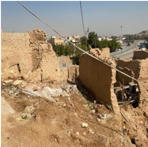
شكل رقم (١٧): حالة المباني والتي تحتاج إلى تقوية الأساسات وإعادة بناء حوائطها مع المباني: (من تصوير الباحث)
