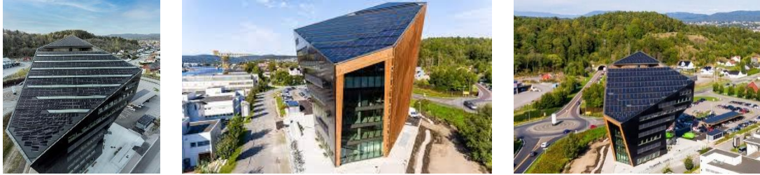
شكل (4) يوضح الواجهة المعمارية لمبنى Powerhouse Telemark - تصميم شركة Snohetta - تيلمرك، النرويج - 2020م تحليل القيم الوظيفية والجمالية للواجهة المعمارية:
