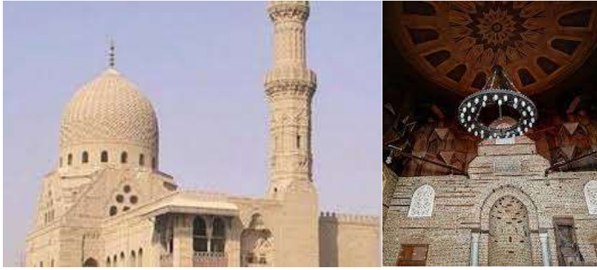
شكل (3) مسجد الظاهر بيبرس https://www.google.com/search?sca_esv=0d2152f041f38e62
