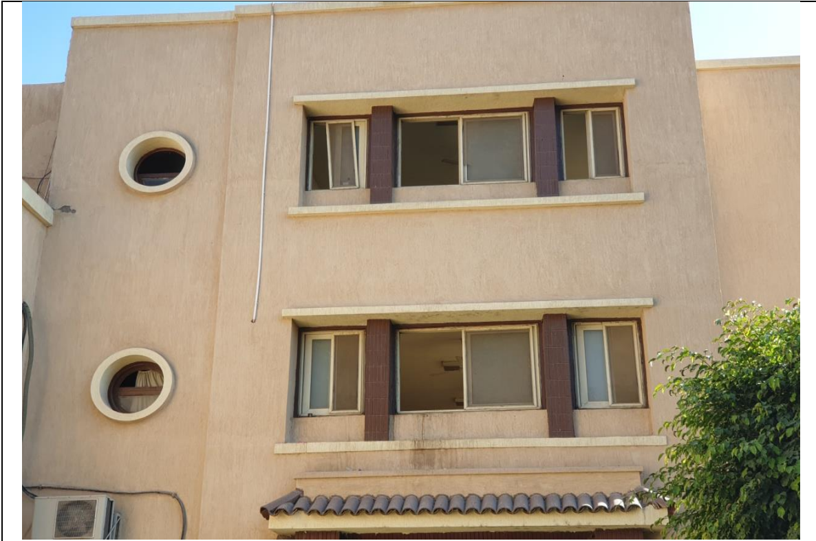
لوحة (١٥) واجهة الصالة الرئيسية التي توضح النوافذ بأشكالها المختلفة الموجودة بالمستشفى. (تصوير الباحثة)
