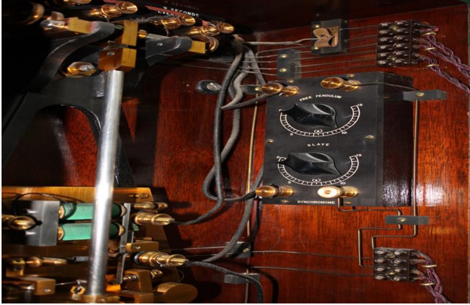
(لوحة ١٦) توصيلات مفاتيح الثواني الوحدة الثانوية المتزامنة باللاحقة بالصندوق الخشبي © تصوير الباحث
