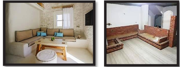
شكل (١٨): بناء أثاث و جلسات غرفة للمعيشة بالطوب الأحمر.
