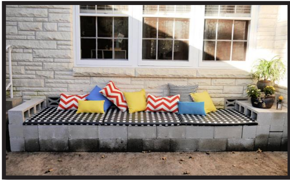
شكل (٢٠): مراحل تكوين جلسة خارجية من الطوب الأسمنتي، ووضع حشوة علوية من الإسفنج والخشب وكسوتها بالقماش
