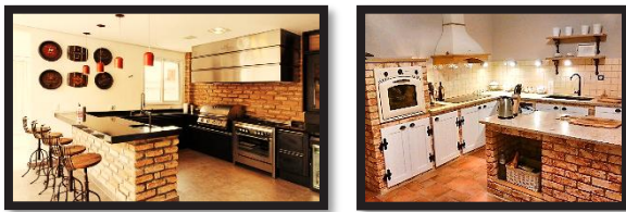
شكل (١٩): استخدام الطوب الأحمر في بناء قطع المطبخ التخزينية دون تكسية السطح بالدهانات أو غيرها.
