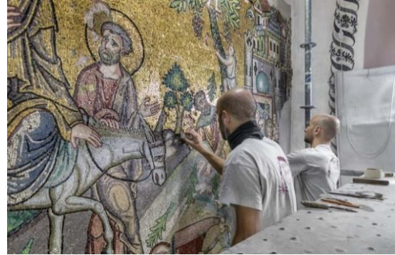
(شكل ٢) أثناء إجراء بعض أعمال ترميم الشركة الإيطالية لفسيفساء "كنيسة المهدي"
