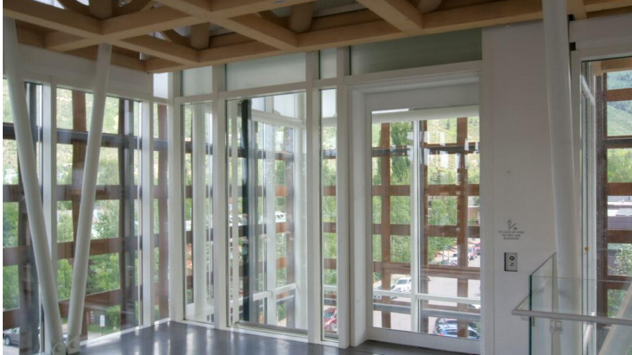
صورة (٨) توضح حائط مقاوم للحريق لمدة ساعتين مصنوع من الزجاج بمتحف اسبن للفنون بأمريكا . https://safti.com/case-studies/fire-resistive-curtain-wall-at-aspen-art-museum 15.7.2024.
