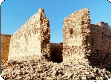
(لوحة ٢٧) البرج الجنوبي الغربي (١٩) المهدم حالياً بقلعة آبار الغنم (تصوير الباحث)
