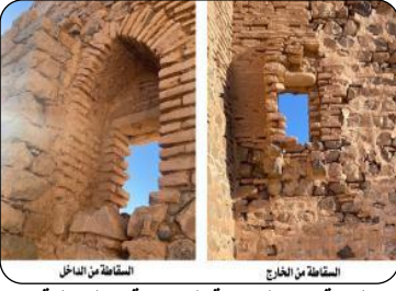
(لوحة ٣٠) الواجهة الخارجية و الداخلية للسقطة بالجهة الشمالية الشرقية من السور الحجري بالضلع الشمالي الغربي للدور الأول لقلعة آبار الغنم (تصوير الباحث)
