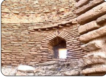
(لوحة ٣٢) الدور الأول وسطح البرج للبرج الشمالي الشرقي (٣١) بقلعة آبار الغنم (تصوير الباحث)
