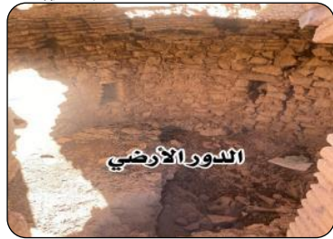
(لوحة ٢٤) فتحات مزاغل البنادق بالدور الأرضي للبرج الجنوبي الشرقي (١٢) لقلعة آبار الغنم (تصوير الباحث)
