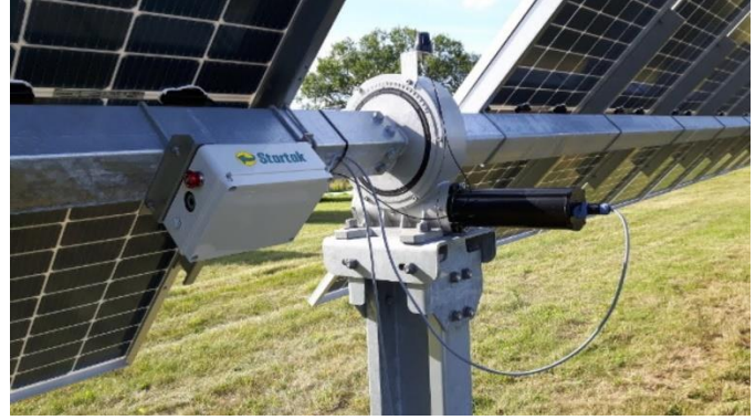
شكل ١٢: جهاز التعقب الشمسي للخلايا الفوتو فولتية، المصدر: Gevorkian, 2008.
