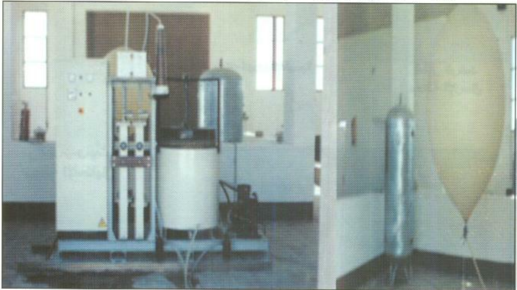
جهاز تحضير هيدروجين فرنسي الصنع يعمل بكل من مطروح والغرافة وقنا (شكل ٥ ب)
