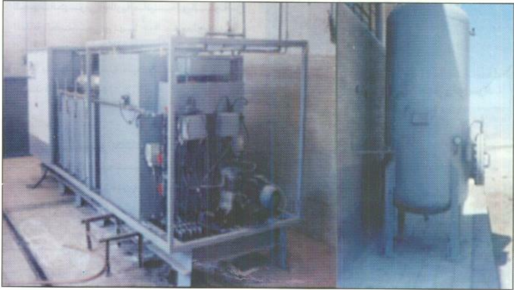
جهاز تحضير هيدروجين إنجليزي الصنع يعمل في كل من حلون - أسوان - العريش (شكل ٥ أ)
