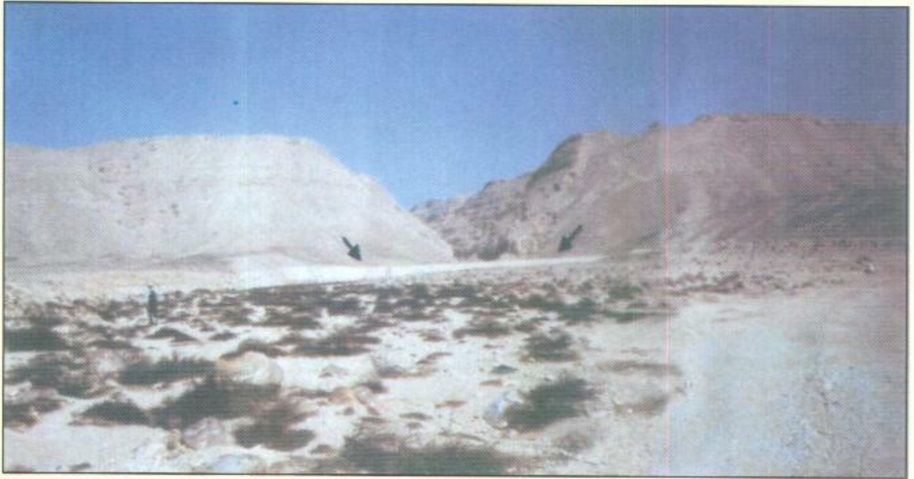
أحد سدود الإعاقة المقامة على الجزء الأدنى من وادى الهمامية بهدف التقليل من سرعة وخطر السيل
