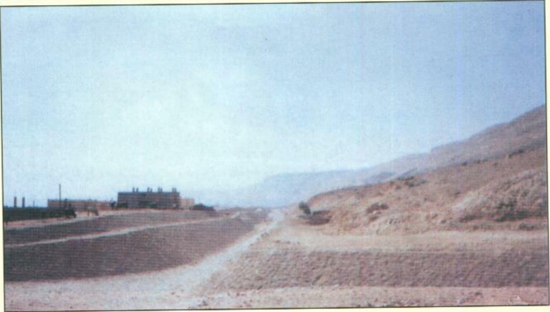
إنشاء مخزرات سيول فرعية من المخر الرئيسي لواءى درنكة لتقليل حجم التصريف المائى فى المخر الرئيسي.
