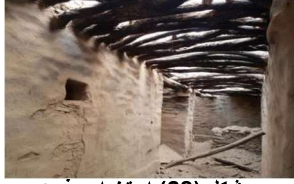
شكل (28) استخدام جذوع الأشجار المحلية ومعالجتها ضد عوامل التآكل
