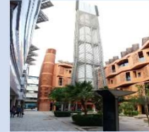
أبراج التهوية بساحة المبنى.
