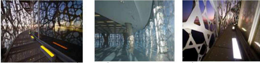
شكل الغلاف الخارجي وتأثيره في إلقاء الظلال بالمسافة الفراغ بين أغلفة المبنى وتأثير ذلك على الفراغات الداخلية شكل (15): يوضح منظر عام لبرج الدوحة وشكل الغلاف الخارجي والمسافة الفراغ بين أغلفة المبنى [47].
