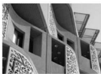
شكل (3): يوضح تركيب الواح من الخرسانة المسلحة بالألياف الزجاجية (GRC) على شكل شبكة على البلوكونات [29].
