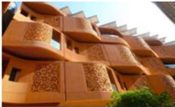
شكل (3): يوضح تركيب الواح من الخرسانة المسلحة بالألياف الزجاجية (GRC) على شكل شبكة على البلوكونات [29].
