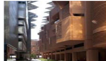
شكل (2): يوضح ضيق عرض الشوارع وتموج البلوكونات وزيادة بروزها من أجل القاء الظل في الشوارع عاكس فترة ممكنة [26].
