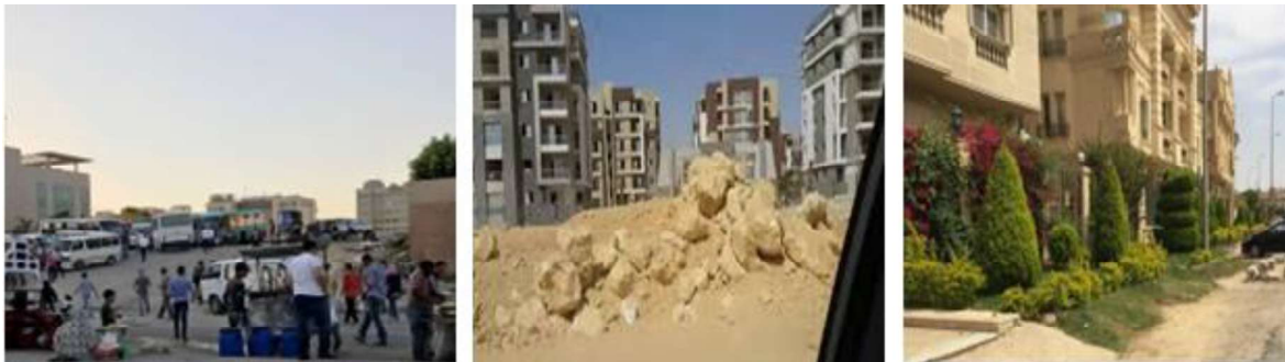
شكل (18): يوضح عدم تخصيص ممرات للمشاة وتحويل الأرصفة إلى حدائق خاصة والقاء ناتج الحفر على الأرصفة واستغلال الباعة لها واتساع عرض الشوارع [الباحث].
