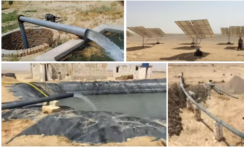
صورة(٢) مخطط يوضح استخدام الطاقة الشمسية لاستخراج المياه بواسطة محرك ٢٥ حصان بوادي قنا
