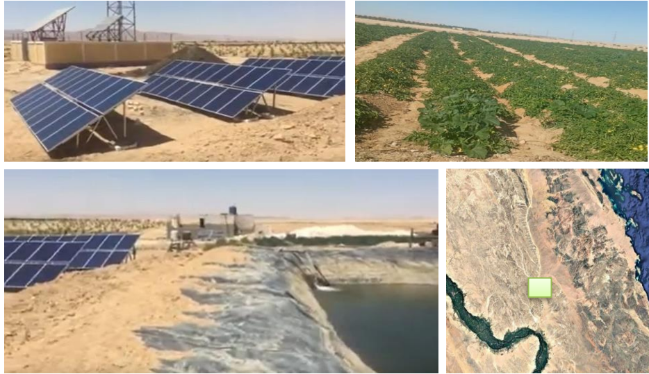
شكل(١) مخطط يوضح استخدام المياه الجوفية والطاقة الشمسية للري بحوض وادي قنا.
