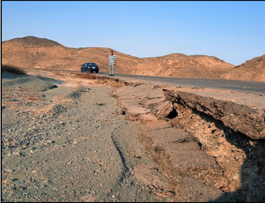
صورة (٤) : تعرض أجزاء من طريق قفط - القصير للتقويض السفلي والسقوط، ناظرًا صوب الشمال الغربي.
