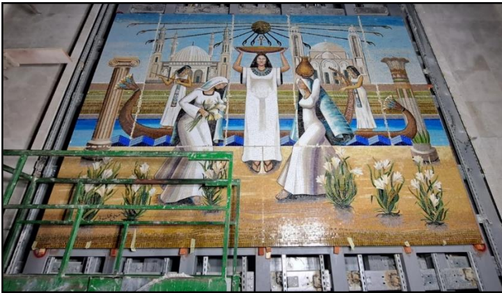
شكل رقم ( 70 ) يوضح إكمال تجميع أجزاء الجدارية والإنتهاء من تركيبها
