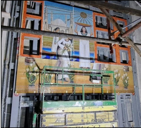
شكل رقم (68) تركيب لوح الخشب على اليسار
