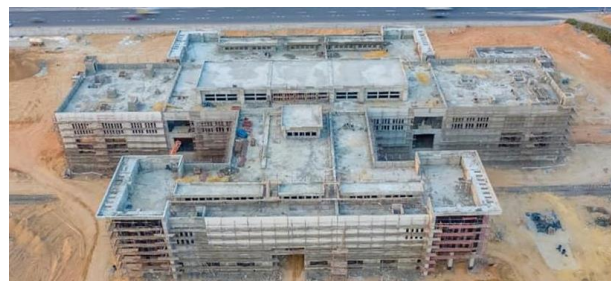
شكل 29: لقطة جوية لمحطة المستقبل LRT أثناء التنفيذ وبعد التشغيل. [30]
