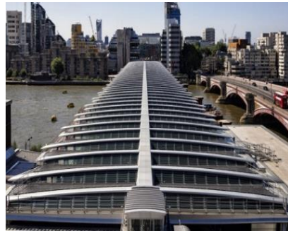
شكل 15: تغطية سطح الأرصفة بكاملة ب 4400 لوح طاقة شمسية كحل أخضر لتوليد الطاقة. [18], [19]
