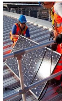
شكل 15: تغطية سطح الأرصفة بكاملة ب 4400 لوح طاقة شمسية كحل أخضر لتوليد الطاقة. [18], [19]
