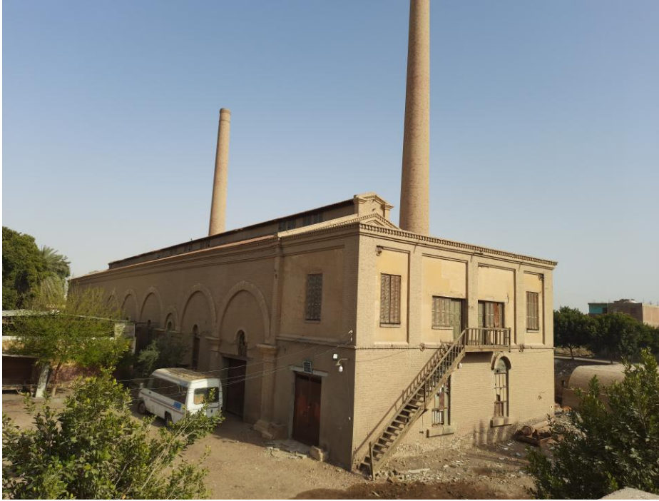
(٢٨) الواجهة الشمالية مع الغربية ويظهر بها مكتب المدير المضاف بعد عام ١٩٣٥م ويظهر بها فانوس سقف بولونسو الجمالوني من أعلي خلف مكتب المدير "تصوير الباحث"
