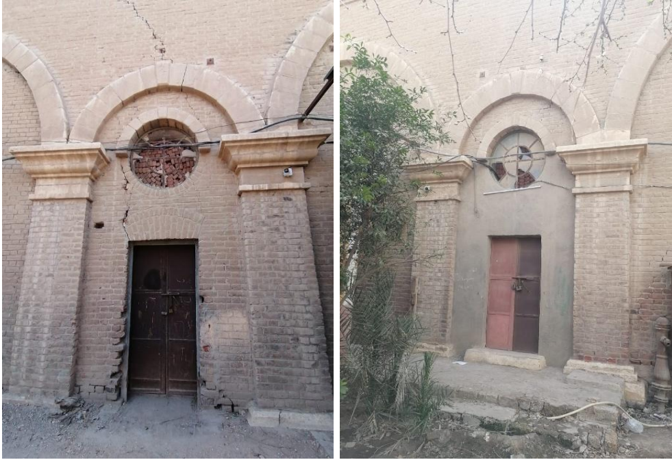
(٣٢) تفاصيل المدخلين الغربي والشرقي ونافذة عين الثور التي تتوجه في الواجهة الشمالية ويتوج كل نافذة فرنتون نصف دائري مقوس "تصوير الباحث"
