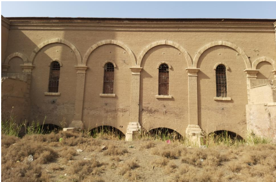
(٢٧) تفاصيل من البلك المركزي للواجهة الجنوبية حوض المص وقنوات التوصيل والعضادات الدورية الممتدة والعقود الكلاسيكية والنوافذ المعقودة ذات الفرنتونات البسيطة والكورنيش الرئيسي وزخرفة الاسنان والخ "تصوير الباحث"
