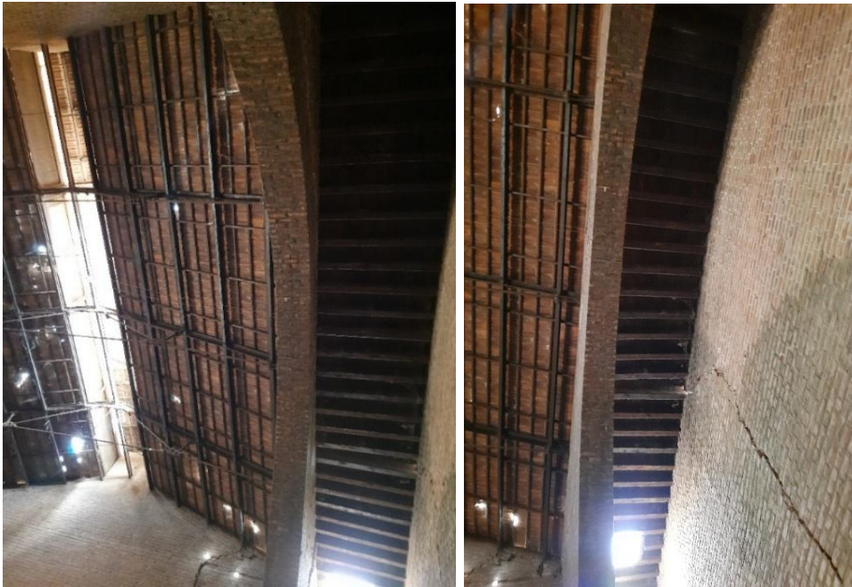
(٥٢) تفاصيل لسقف حجرة الغلايات الشرقية وممر البواكي البارز في الجهة الجنوبية المسقف بسقف من البراطيم الخشبية "تصوير الباحث"
