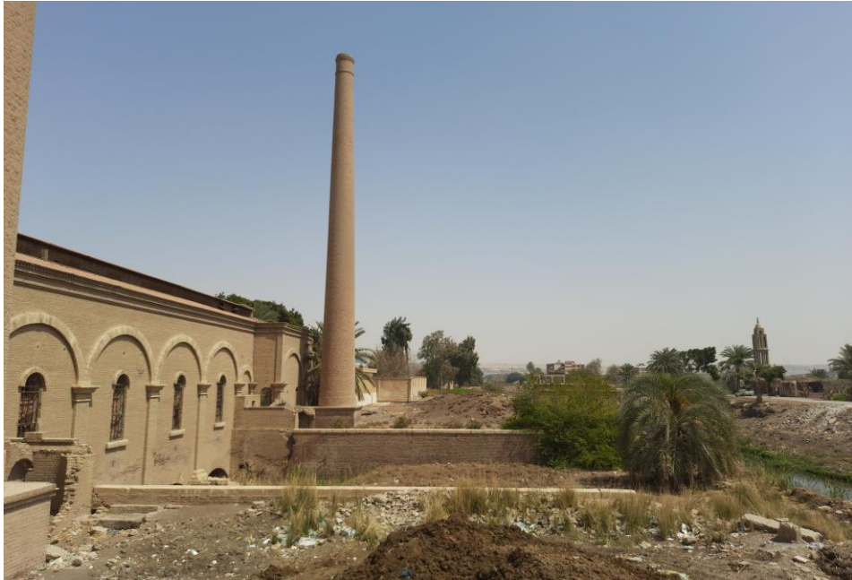
(٢٦) تفاصيل من الواجهة الجنوبية سور او جوانب مجري المص وحوض المص الذي يفتح علي ترعة اطسا والمدخنة الشرقية "تصوير الباحث"
