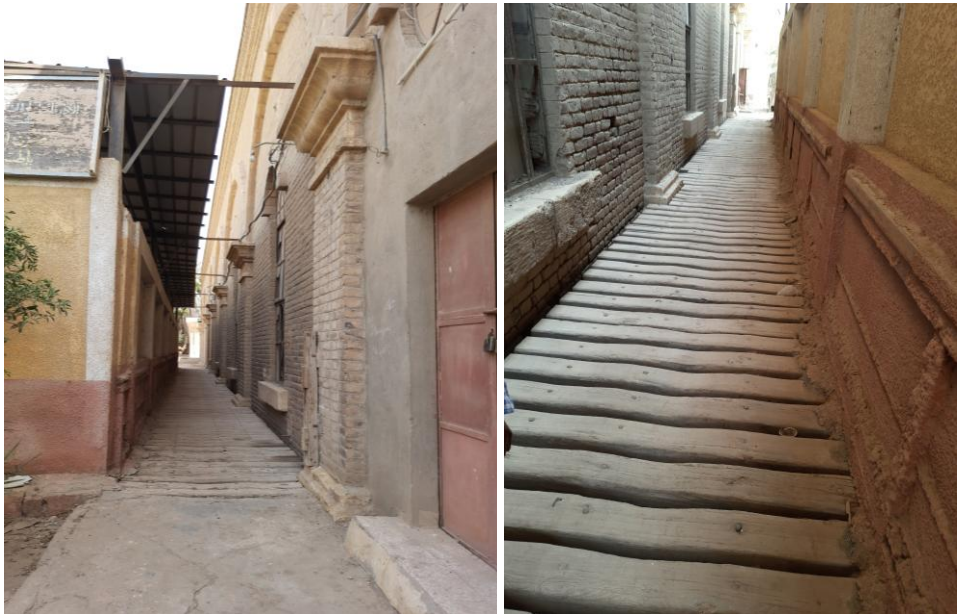
(٣٣) الفلنكات التي كان يسير عليها الونش الذي كان يحرك بوابات حوض الطرد في الواجهة الشمالية أمام البلك المركزي الأوسط التي حل محلها المخزن الحديث "تصوير الباحث"
