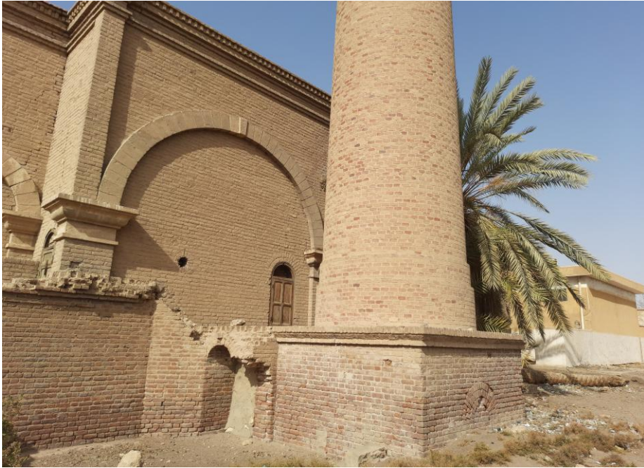
(٤٣) تفاصيل من المدخنة الشرقية والباب المؤدي للمدخنة من الخارج أسفل رجل العقد وبقايا الممر المؤدي علي شكل حرف "U" الي عنبر الظلمبات من الداخل "تصوير الباحث"
