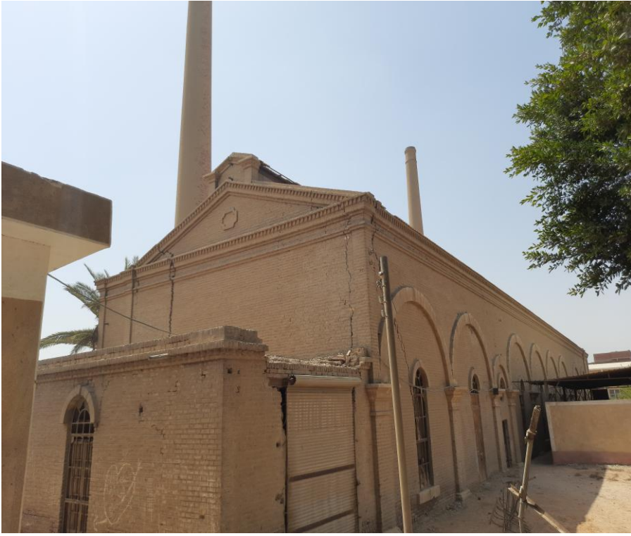
(٣٤) الواجهة الشرقية مع الشمالية ويتقدمها المخزن الحديث لمبنى الظلمبات "تصوير الباحث"
