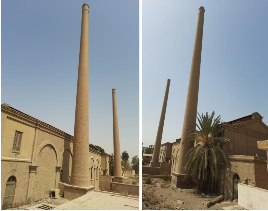
(٢٠) الوجة الجنوبية الرئيسية لمحطة ظلمبات اطسا المطلة على ترعة اطسا من الناحيتين الشرقية والغربية لمبني الظلمبات ويتقدمها حوض ومجري المص "تصوير الباحث"
