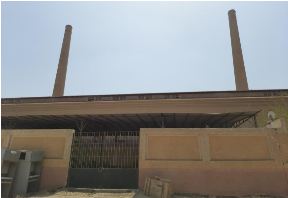
(٤٤) الواجهة الشمالية والمخزن الحديث الذي شيد محل حوض الطرد ومجري الطرد وترعة او قناة التحويل بعد ردمها وتوقف عمل المحطة "تصوير الباحث"
