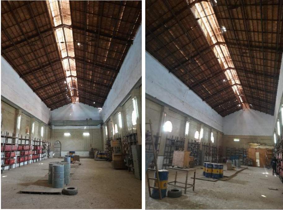
(٤٥) منظر عام داخل حجرة المحركات او عنبر الظلمبات ويظهر به الرافعة العلوية المتحركة او الونش الذي يحمل المحركات في الجهة الشرقية من عمل ايبستون واندرسون عام ١٩٠٢م مع تفاصيل لسقف الحجرة الجمالوني بولونسو أو فينك والفانوس الذي يتوجه "تصوير الباحث"
