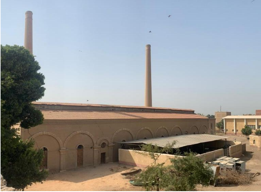
(٣) منظر عام لمبني محطة ظلمبات اطسا من الناحية الشمالية ويتقدمه المخزن الحديث الذي حل محل حوض ومجري الطرد وترعة او قناة التحويل "تصوير الباحث"
