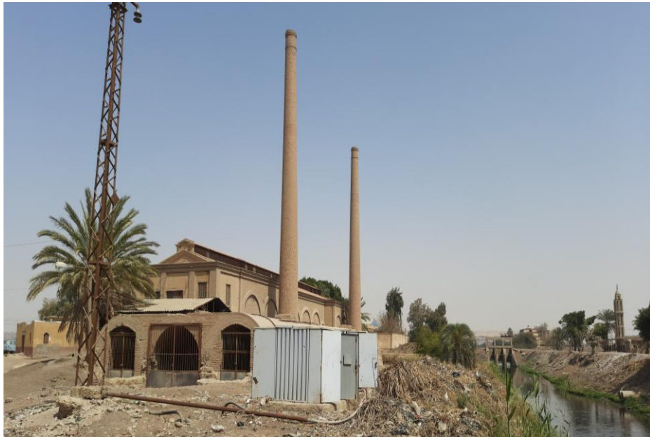
(٢) منظر عام لمبني محطة ظلمبات اطسا والمداخن من الناحية الجنوبية الغربية جهة الابراهيمية على ضفة ترعة اطسا "تصوير الباحث"
