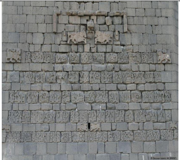
(لوحة 52) واجهة برج ملكشاه بقلعة ديار بكر عن: Hazırlayan; Diyarbakır Surları'nda, p, 74.
