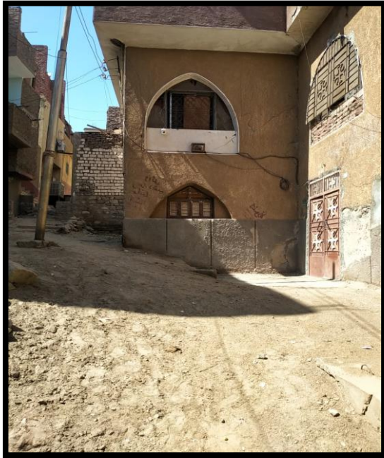
(لوحة رقم 8) واجهة كنيسة السيدة العذراء بشارع عباس فريد ويظهر بها عدم اختلاف واجهتها عن المباني المجاورة تصوير الباحثة
