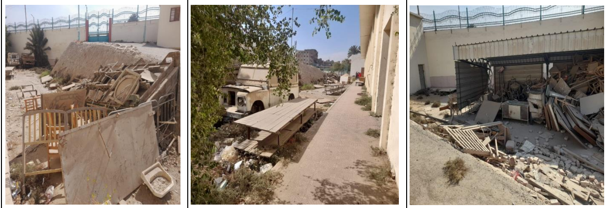
شكل(10-1)صورة توضح اشغال بعض مسطحات الحيز المفتوح بالمخلفات(المصدر الباحث)
