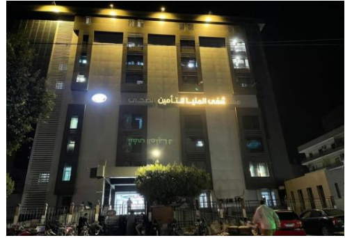
شكل رقم (١٦) تأثير الاضاءة الليلة على مبنى مستشفى المنيا للتأمين الصحي، خلال فترات الليل،
