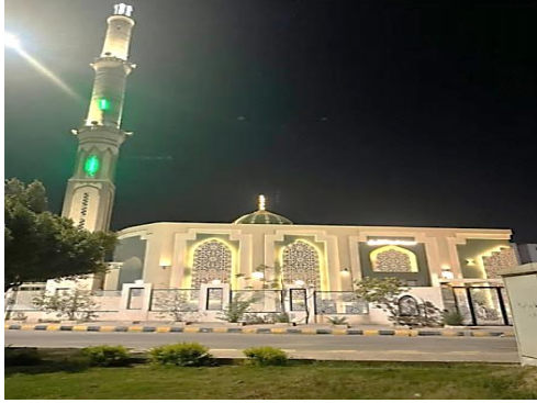
شكل رقم (١٨) اضاءة مبنى مسجد محمد الطويل بمدينة المنيا الجديدة خلال فترات الليل والنهار
