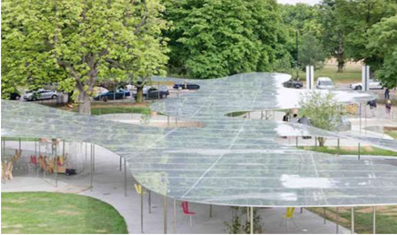
رسم توضيحي ٢٣ الاسقف المصنوعه من الاكليك بمعرض سربنتاين (Serpentine pavilion) ببريطانيا عام ٢٠٠٩ /https://www.dailytonic.com/serpentine-gallery-pavilion-2009-by-sanaa
