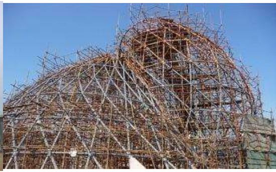
رسم توضيحي ٩ النظام الإنشائي في قاعة اسرائيل بمعرض أكسبو ٢٠١٠ بشنغهاي ، عبارة عن جمالونات فراغية معدنية بار ارتفاع ٢٤ متر
