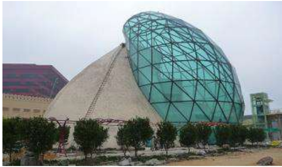
رسم توضيحي ٩ النظام الإنشائي في قاعة اسرائيل بمعرض أكسبو ٢٠١٠ بشنغهاي ، عبارة عن جمالونات فراغية معدنية بار ارتفاع ٢٤ متر
