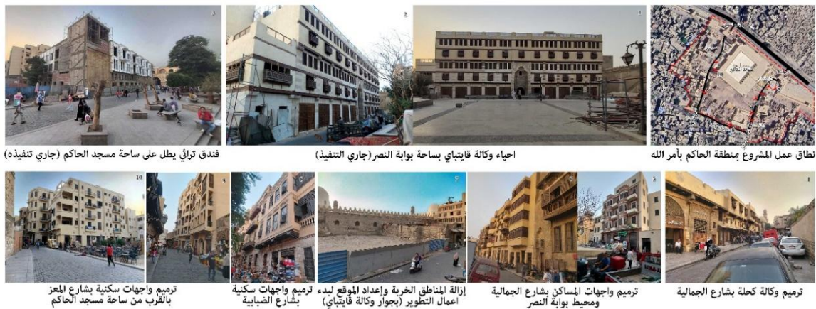
شكل (16) الوضع الراهن بمنطقة الحاكم، حيث يجري ترميم وكالة قايتباي، وإنشاء فندق تراثي، وإزالة المناطق الخربة والمتدهورة، وترميم واجهات المنازل التي تحقق السلامة الإنشائية. المصدر: عمل وتصوير الباحث، (خريطة أساس Google Earth)
