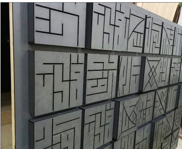
شكل (١٣) تجميع أوجه المكعب من خلال تجميع ٣٥ مكعب في كل وجه ، ثم تركيب أوجه المكعب على الهيكل الداخلي. (المصدر: الباحثة).
