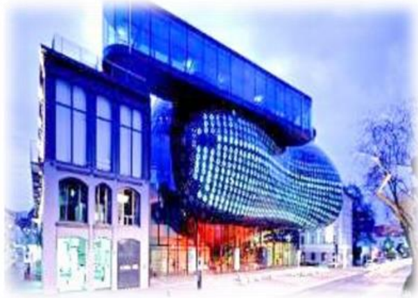
شكل (١) يوضح الشكل الخارجي لمبنى Kunsthau Graz بأستراليا
